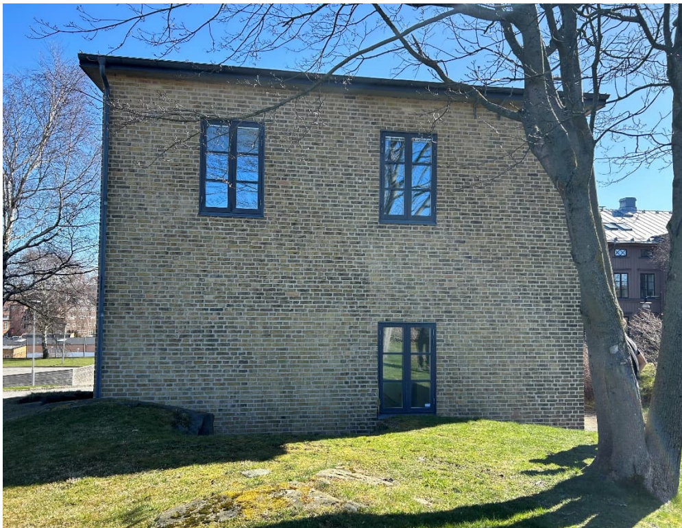
Figur 2: Översikt mot sydväst av byggnaden inom fastigheten GÖTEBORG LINDHOLMEN 6:11.
